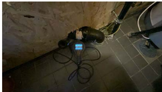
Utført fuktmåling i svill.
