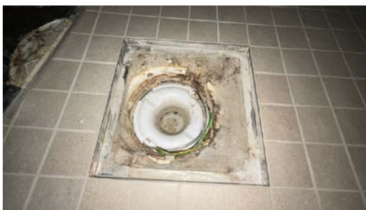
Kontroll av sluk.
