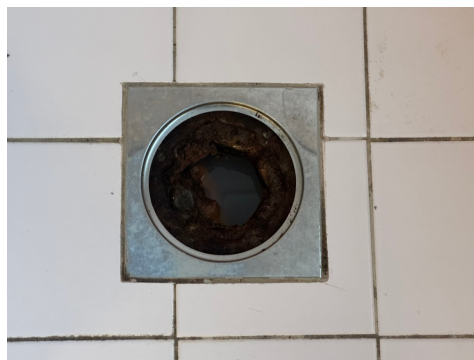
Eldre støpejernsluk i gulv.
