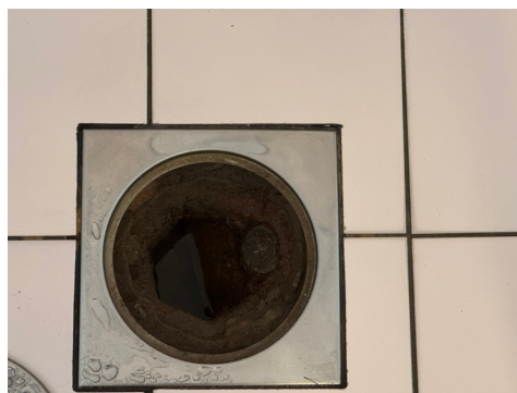
Eldre støpejernsluk i gulv.
