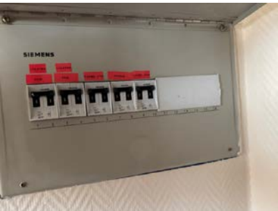
Sikringsskap i entre i tilbygd del.
