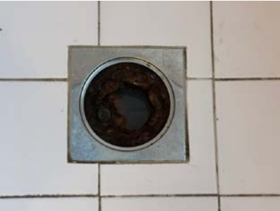
Eldre støpejernsluk i gulv.
