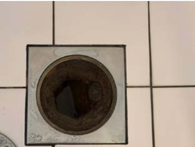
Eldre støpejernsluk i gulv.
