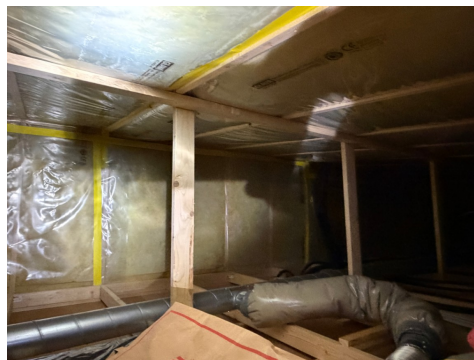
Synlig del av takkonstruksjon ble besiktiget fra loftsluke.
