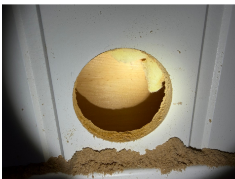
Måling av relativ luftfuktighet.
