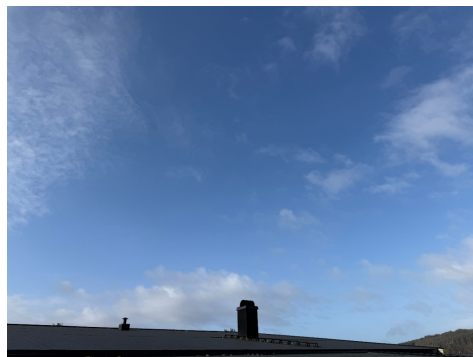
Taktekking sett fra bakkenivå.
