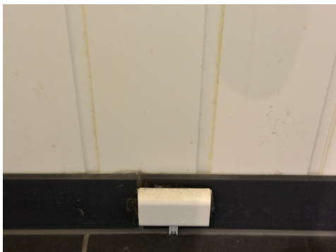
Aquastop v/ gulv.
