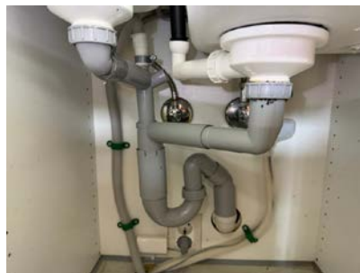
Rørøpplagg og aquastop under vask.
