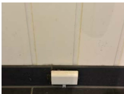
Aquastop v/ gulv.
