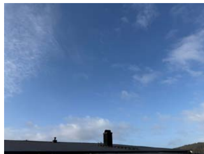
Taktekking sett fra bakkenivå.
