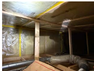
Synlig del av takkonstruksjon ble besiktiget fra loftsluke.
