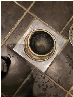
Tettesjiktets tilslutning til sluk - Sluk
