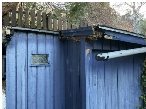
Råteskader
