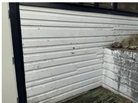
Malingsslitt grunnmur.
