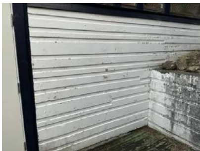
Malingsslitt grunnmur.
