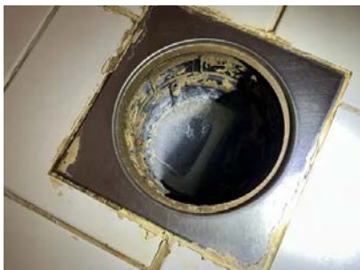
Mangler membran og klemring.
