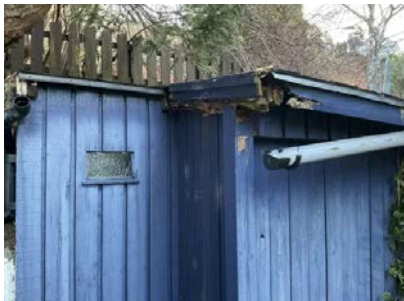
Råteskader
