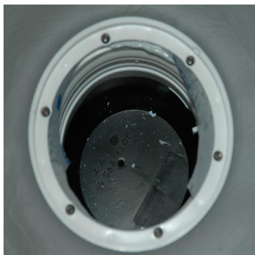
Bildet viser membran ned i sluket med klemring.
