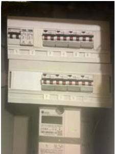
Sikringsskap i felles trappegang.
