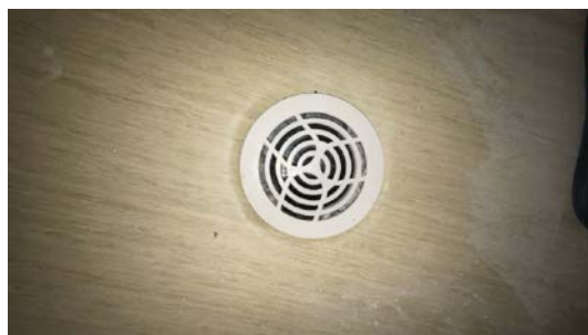
Kontroll av sluk i naborom med åpen vegg.
