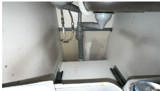
Besiktelse av røropplegg.
