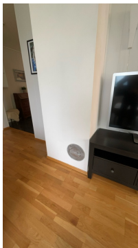
Besiktigelse av pipeløp utvendig.
