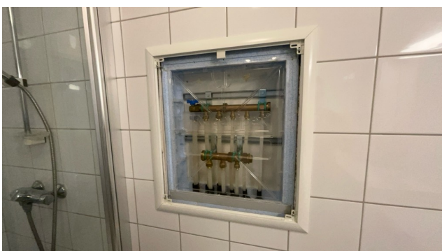
Besiktigelse av røropplegg.
