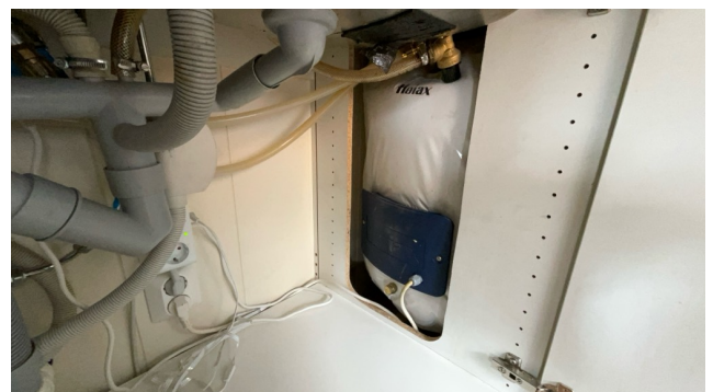
Besiktigelse av bereder.
