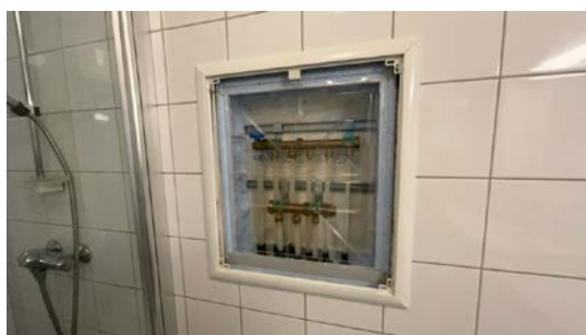
Besiktigelse av røropplegg.
