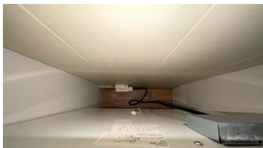
Kontroll bak oven. Ingen tegn til fuktskader på befaringdagen.
