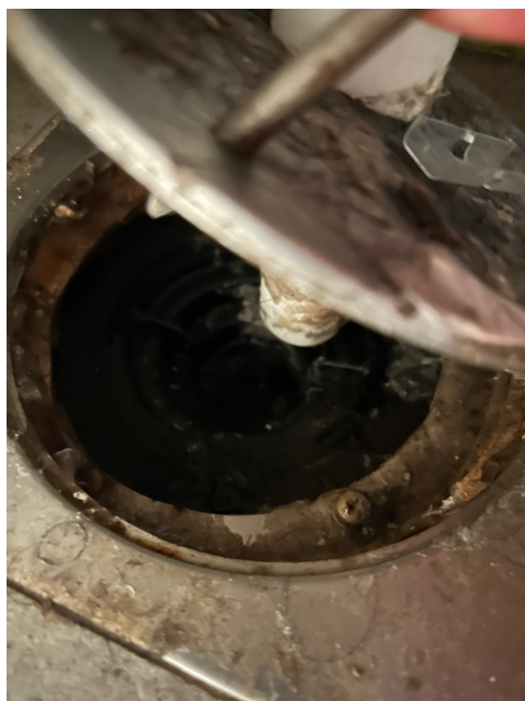
Sluk på bad i U.etasje
