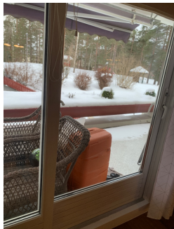
Skyvedør til terrasse med malt karm
