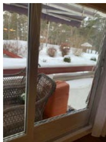
Skyvedør til terrasse med malt karm
