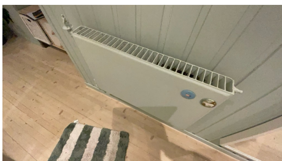
vannbårent varmeanlegg
