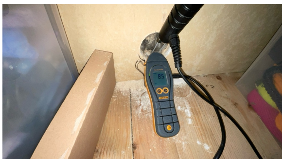
Hulltagning og fuktsøk
