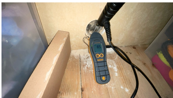
Hulltagning og fuktsøk
