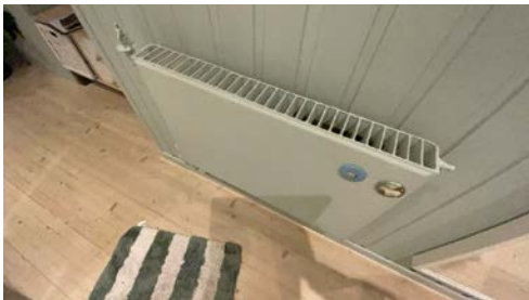
vannbårent varmeanlegg
