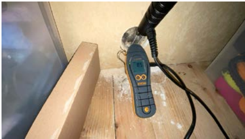
Hulltagning og fuktsøk
