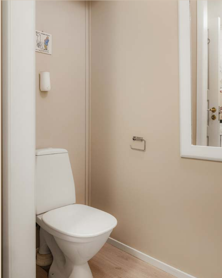
Vaskerom/toalettrom med opplegg for vaskemaskin og varmtvannsbereder.
