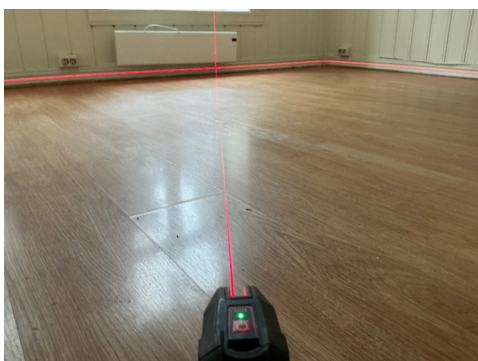
Nivellering stue, ingen avvik registrert
