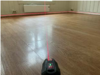
Nivellering stue, ingen avvik registrert
