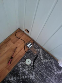
Utført kontroll i tilliggende konstruksjon - Fuktmåling
