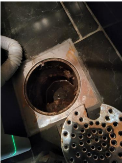
Tettesjiktets tilslutning til sluk - IMG_20260317_135945
