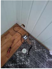
Utført kontroll i tilleggende konstruksjon - Fuktmåling
