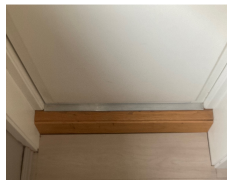
Glippe mellom laminat og utforing.
