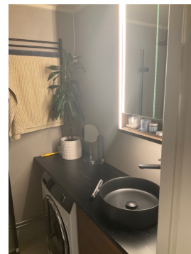
Laminat benkeplate med servant bolle.
