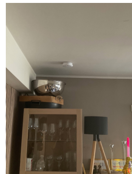
Røykvarsler stue med tilknytning til borettslaget.
