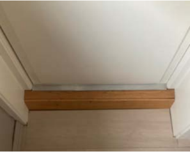
Glippe mellom laminat og utforing.
