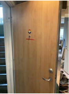
Dør mot trappegang, malt innvendig.
