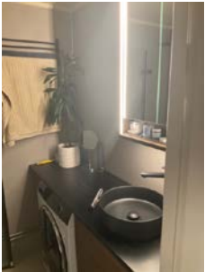
Laminat benkeplate med servant bolle.
