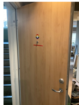
Dør mot trappegang, malt innvendig.
