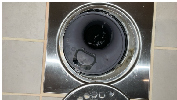
sluk, membran og tettesjikt
