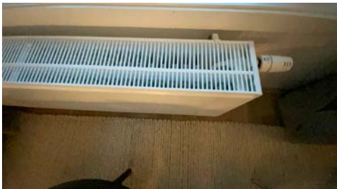
vannbårent varmeanlegg
