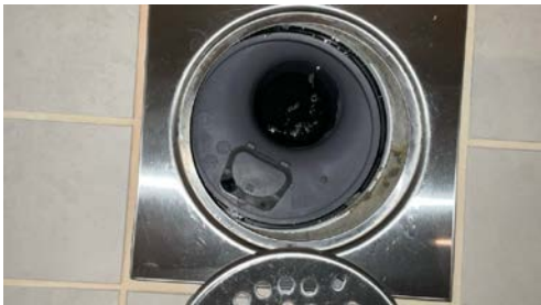
sluk, membran og tettesjikt
