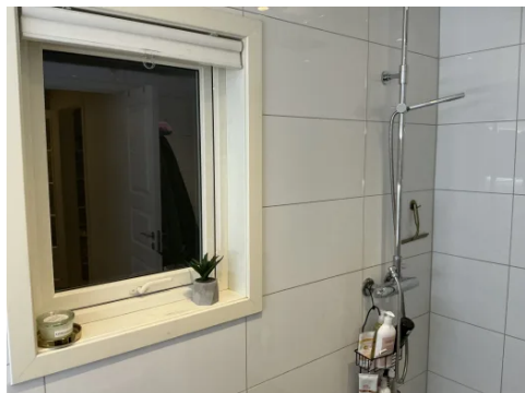
Vindu i dusjsone (TG 2)
