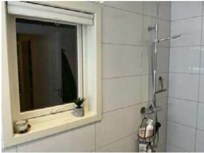
Vindu i dusjsone (TG 2)
