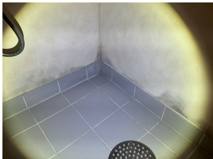
Fuktmerker tapet dusjen
