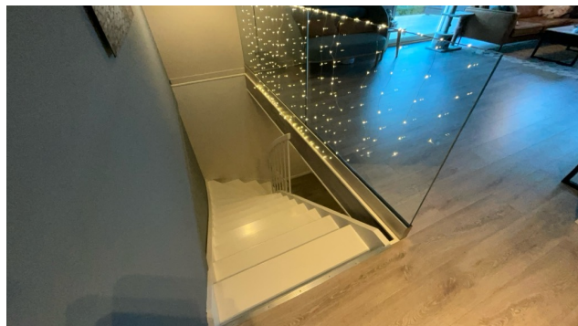
Besiktigelse av trapp.
