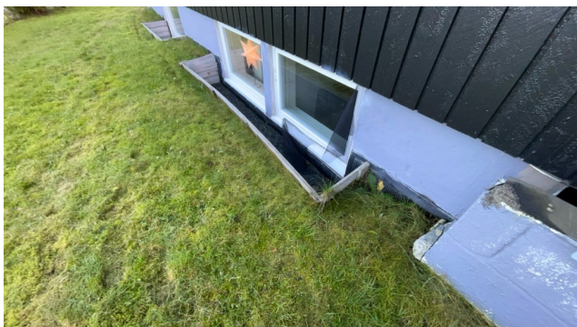
Kontroll av drenering/fuktsikring.
