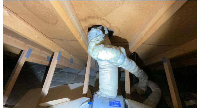
Kontroll rundt rørgjennomføringer.
