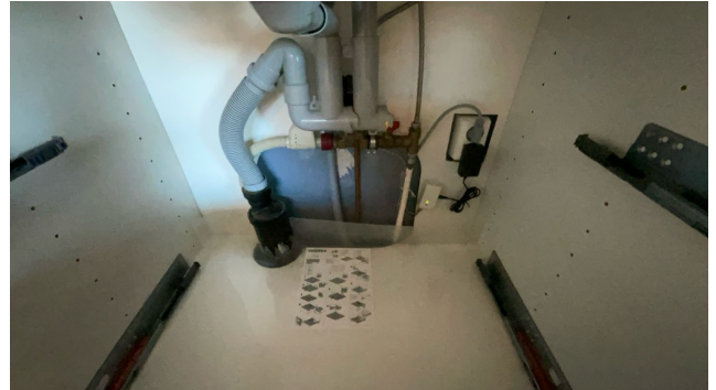
Besiktigelse av røropplegg.
