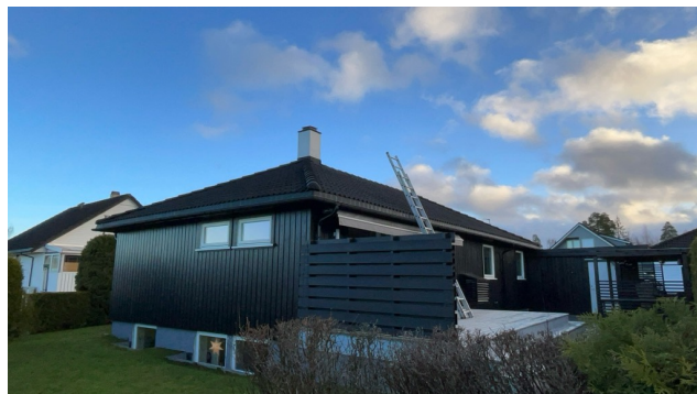
Besiktigelse av taktekke.
