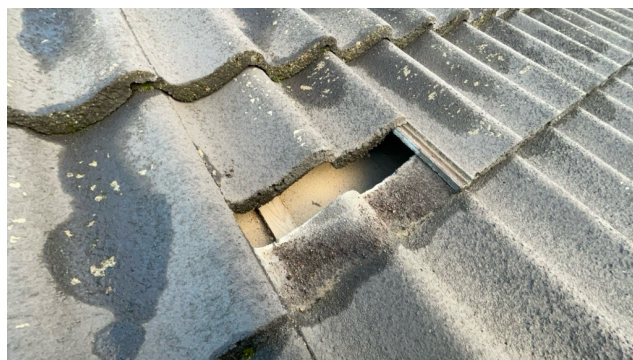
Kontroll av undertak.
