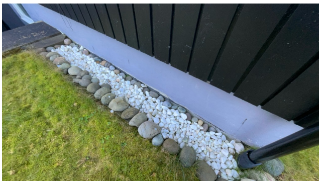
Kontroll av drenering/fuktsikring.
