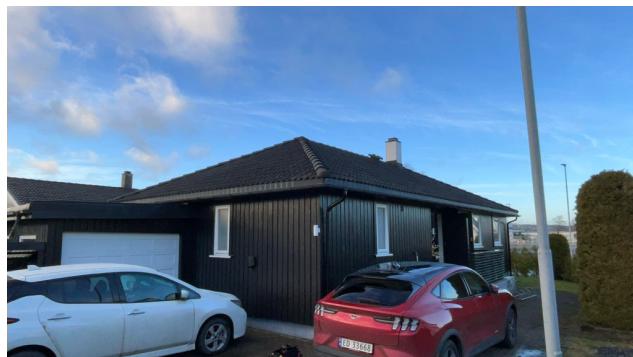
Besiktigelse av taktekke.
