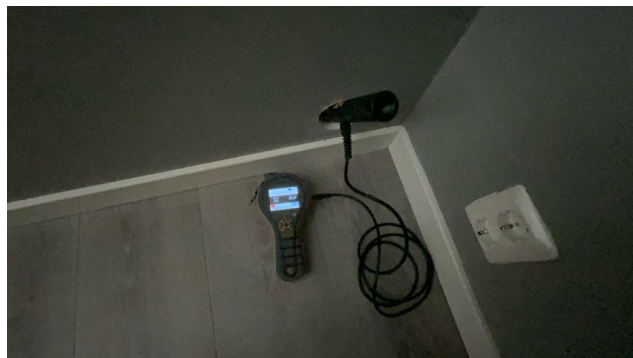
Utført hulltaking på rom under terreng.
