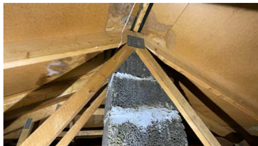
Kontroll rundt pipeløp.
