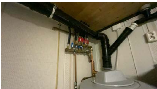
Besiktigelse av rørinspekk.
