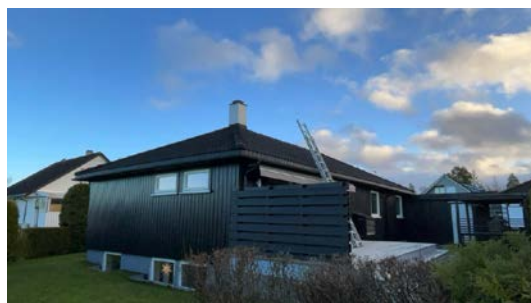
Besiktigelse av taktekke.
