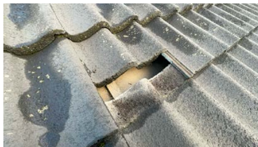
Kontroll av undertak.
