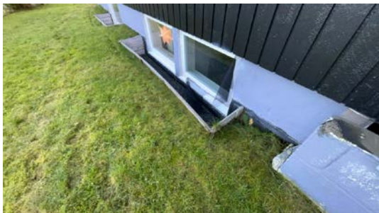
Kontroll av drenering/fuktsikring.
