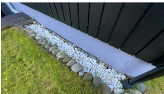
Kontroll av drenering/fuktsikring.
