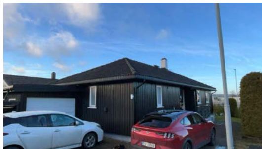
Besiktigelse av taktekke.
