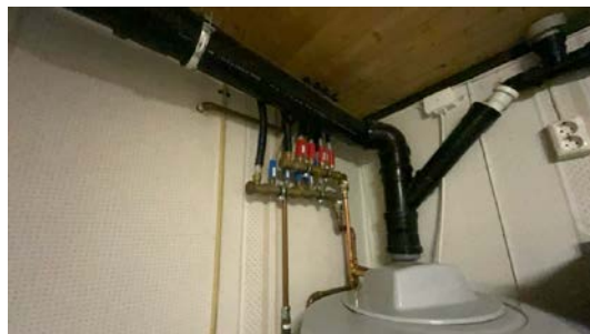
Besiktigelse av rørøpplagg.
