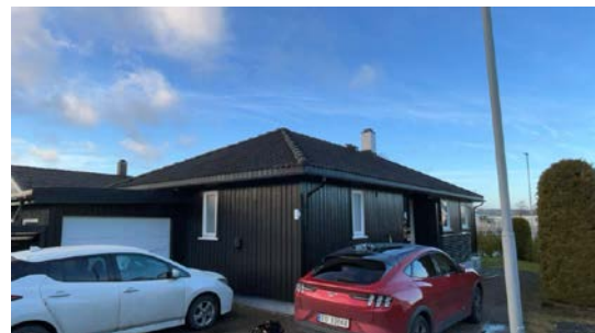
Besiktigelse av taktekke.
