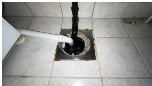
Kontroll av sluk.
