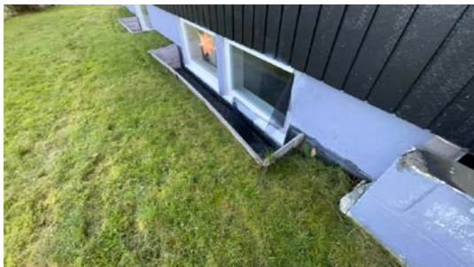
Kontroll av drenering/fuktsikring.
