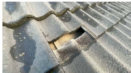
Kontroll av undertak.
