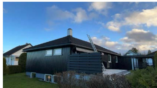
Besiktigelse av taktekke.
