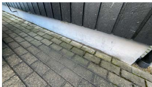
Synlig riss i murpuss.
