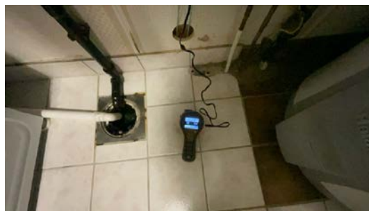
Utført hulltaking.
