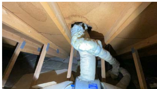
Kontroll rundt rørgjennomføringer.
