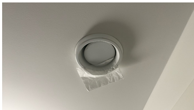
Test av avtrekk i bod.
