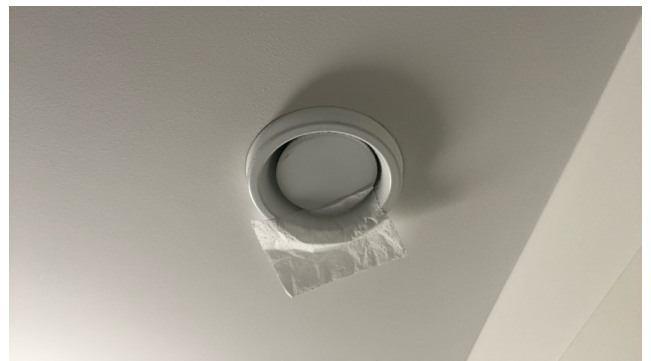
Test av avtrekk i bod.
