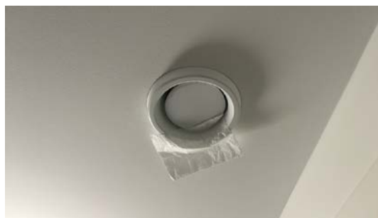
Test av avtrekk i bod.
