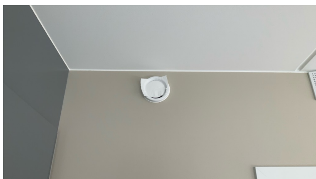
Test av avtrekk.
