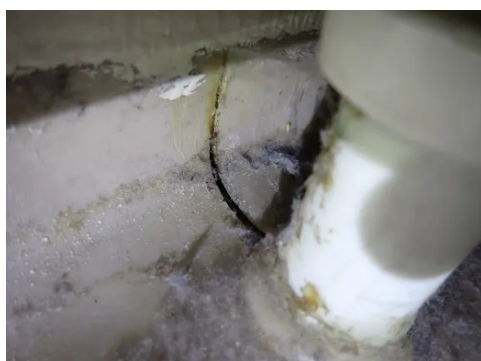
Eksempel på utett skjøt.
