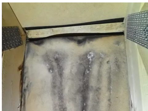
Eksempel på fuktmerker i undertak på kaldtloft ved luftehatt.
