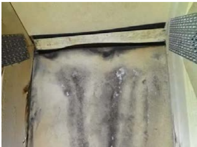
Eksempel på fuktmerker i undertak på kaldtloft ved luftehett.
