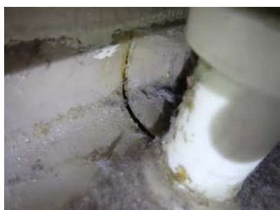
Eksempel på utett skjøt.
