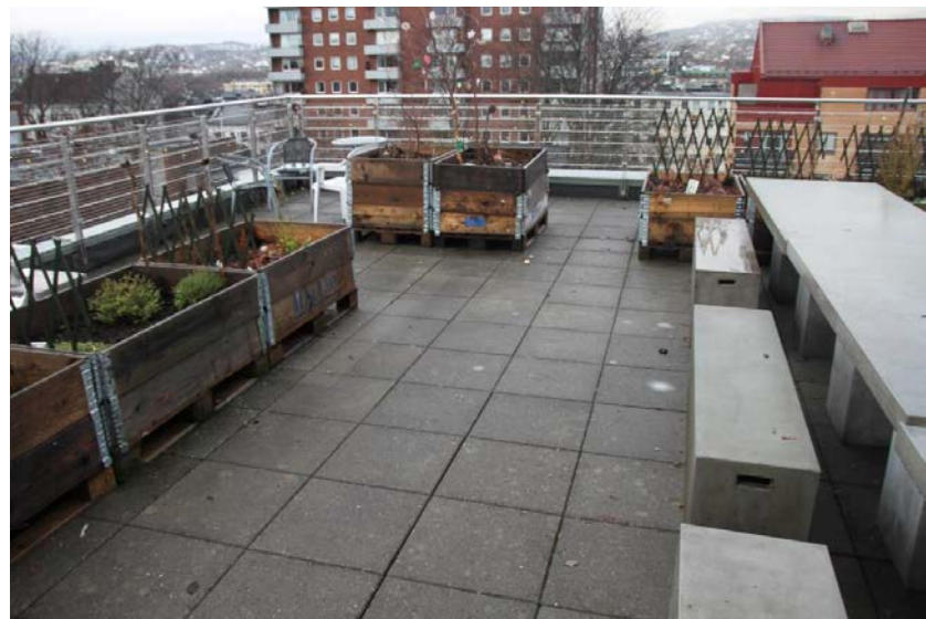
Generelt god tilstand på felles takterrasse.
