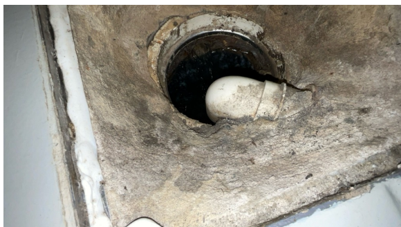
sluk, membran og tettesjikt
