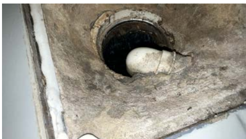
sluk, membran og tettesjikt
