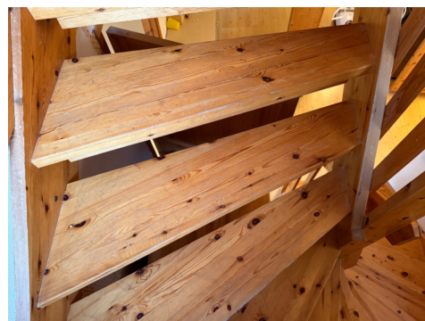
Slitasje/striper i trappetrinn.
