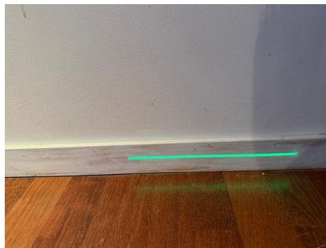
Bilder viser skjevheter i gulv i loftstue.
