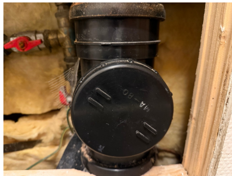
Stakeluke på vaskerom.
