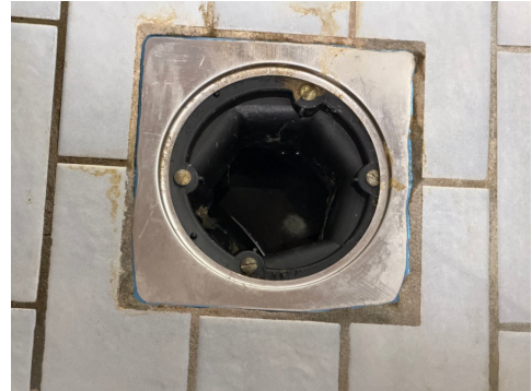
Eldre plastsluk i dusjsone. Ingen tegn til tettesjikt/membran.
