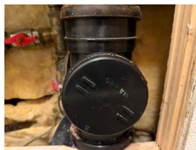
Stakeluke på vaskerom.
