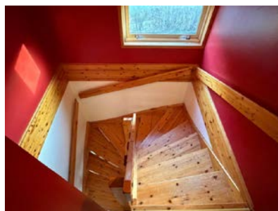
Innvendig trapp mellom hoved-etg - loft-etg.
