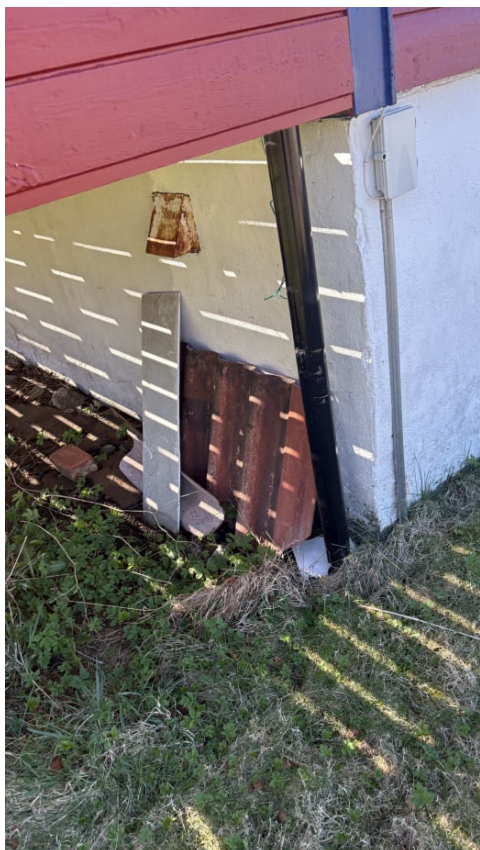
Bildet viser fuktskjolder og saltutslag i grunnmuren.
