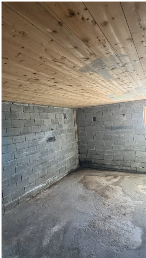
Bildet viser fuktskjolder og saltutslag i grunnmuren.
