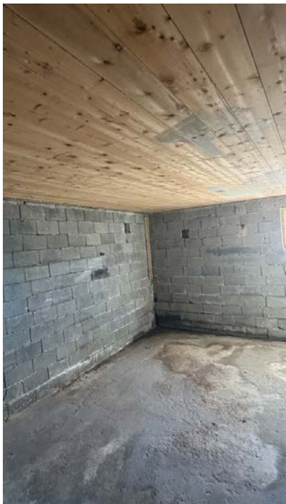
Bildet viser fuktskjolder og saltutslag i grunnmuren.
