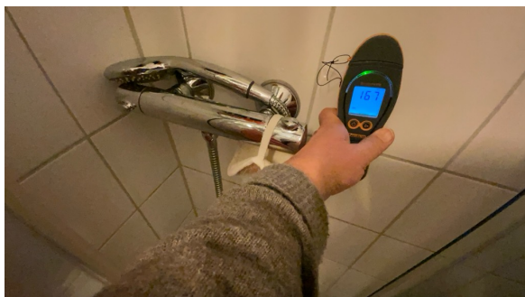
Hulltagning og fuktsøk
