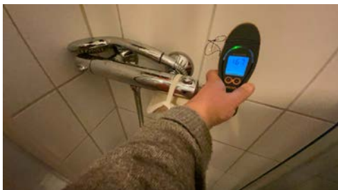
Hulltagning og fuktsøk
